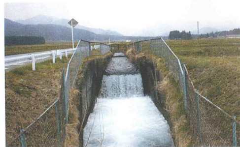
設置前の上段幹線用水路
