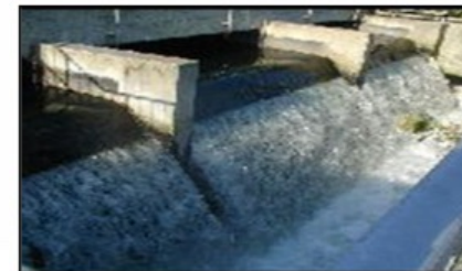
污水處理排水
