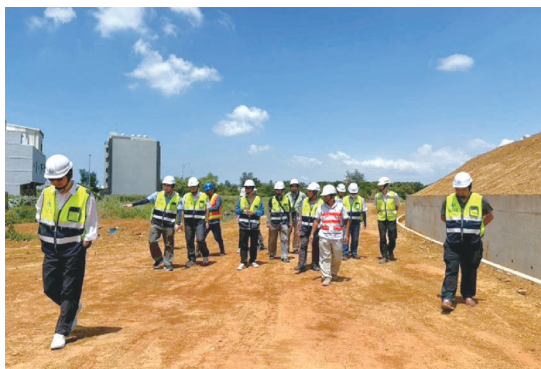
委員工地現場查核情形(相片提供林哲村)
