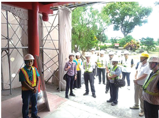
委員現地督導林先生廟重修工程 (照片提供張永忠)
