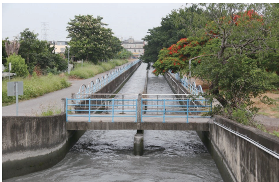
右下 荖仔埤圳幹線第一制水門
