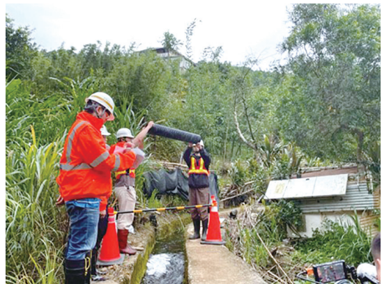
模擬災發生圳路遭阻塞搶修過程
