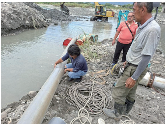
站長現場協調裝設抽水機位置(相片提供宋詩琪)
