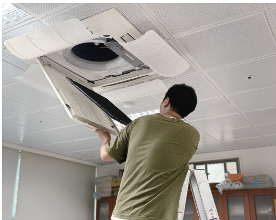
清理冷氣濾網落實節能維護(相片提供張家輔)
