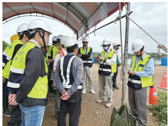
委員現地施工品質查核情形(照片提供林哲村)
