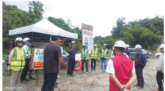
南溪10號圳牧場段改善工程現場查核照片
