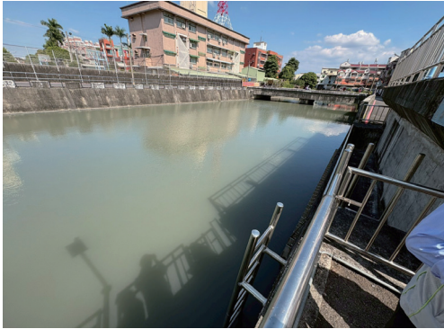
圖1 屏東管理處-永安圳進水口制水門
