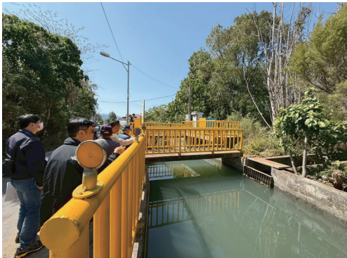
圖3 南投管理處-梅仔腳制水閘門
