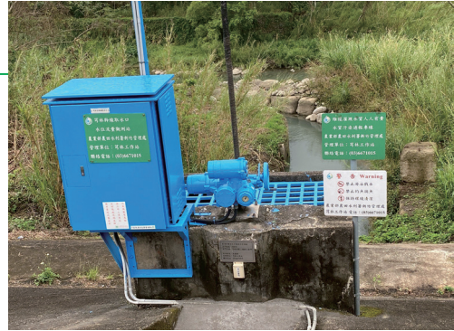
圖2 新竹管理處-芎林圳第二號取水門
