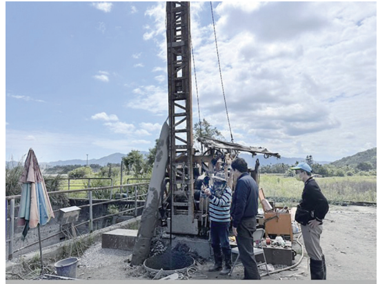
張處長聽取現場人員解說鑿井進度(片提供吳昱錦)
