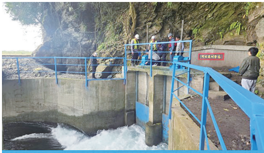
志學圳進水口及導水路現地抽檢 (相片提供邱明慧)
