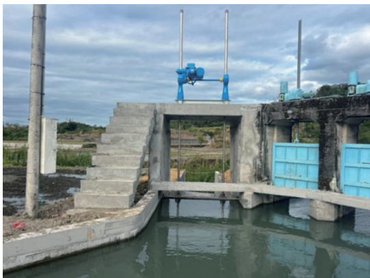
水門更新後可有效疏緩排水，圖為太平渠幹線第5排水門(相片提供黃諭熾)
