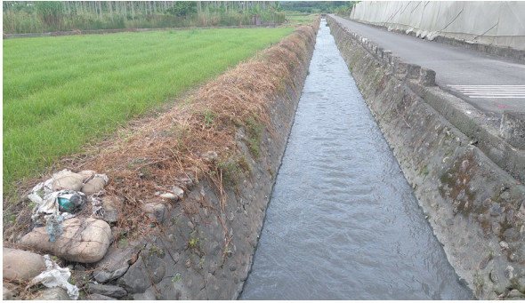
左 內面工的圳路將逐年更新改善為U型溝 右 灌溉水含泥沙量高是舊寮圳待克服的難題
