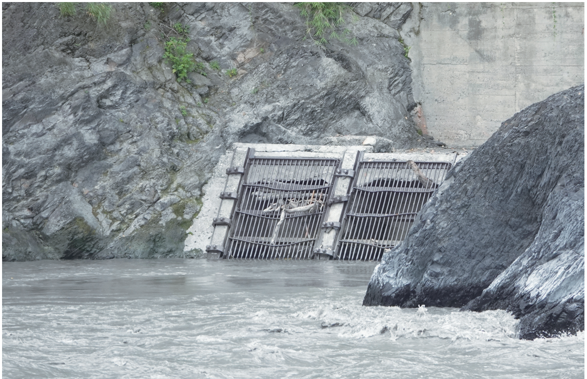
舊寮圳位於濁口溪的進水口
