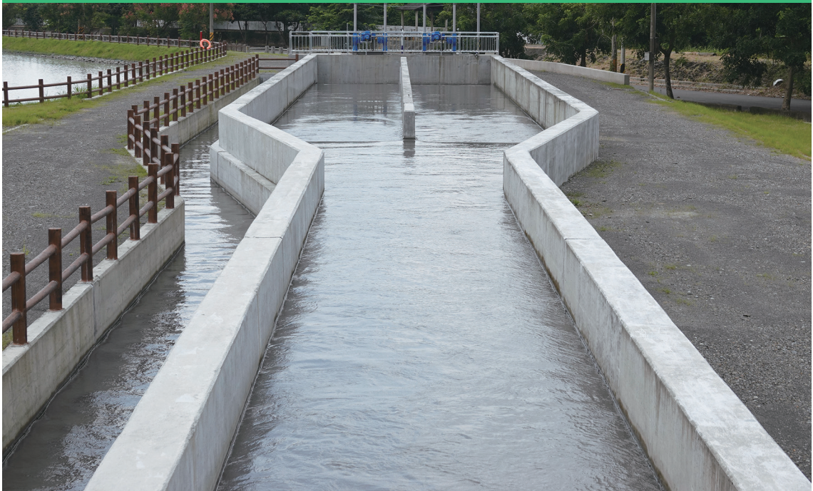
上 舊寮圳沉沙池可以有效降低濁度 下 舊寮圳的沉沙池
