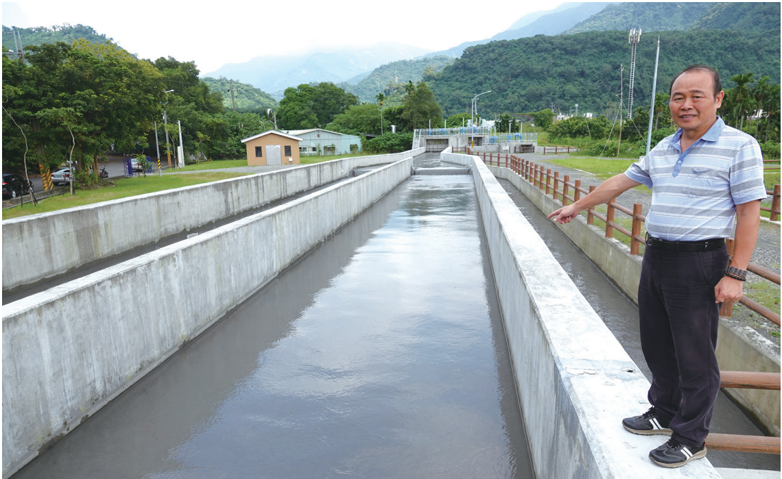
上 舊寮圳沉沙池可以有效降低濁度 下 舊寮圳的沉沙池
