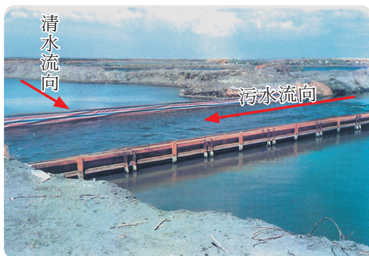
民國72年12月新建試驗性質的污水渡槽
