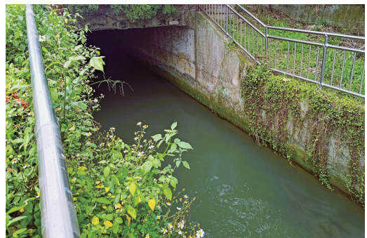
上 后里圳遇山鑿山之圓形渠道斷面 中 后里圳遇水架橋之百歲渡槽 下 后里圳明渠段起始點之矩形斷面
