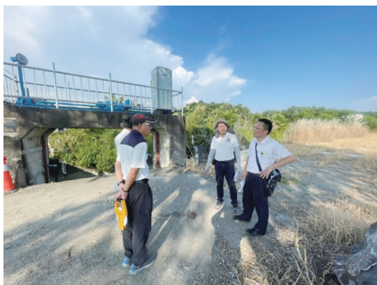
阿罩霧一、二圳連結水路改善工程設計路線勘查
