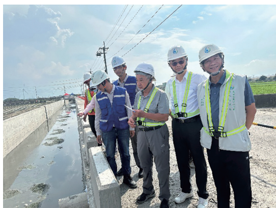
洪銘德總工程司帶隊於上山大排工程現場查核
