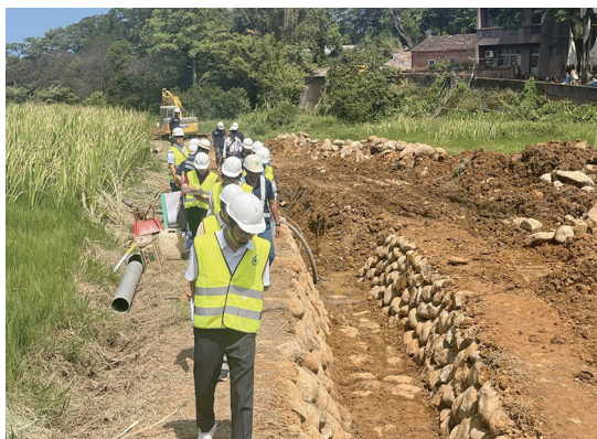
錫板溪擴大灌溉服務設施改善工程現地查核
