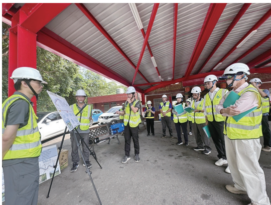
農業部新竹「八輪支線灌排分離工程」施工品質查核
