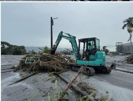
上左 蔡署長勘查大安圳進水口受損情形 上右 大安圳三支線重創 圳路柔腸寸斷 左下 怪手機具進駐 全力清淤大安圳幹線 機具清疏渠道 渠道重見機能
