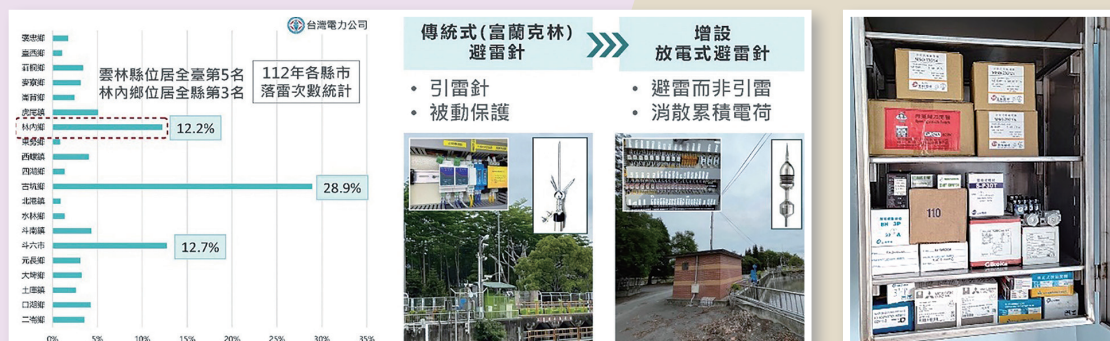
左 圖9 增設放電式避雷針 右 圖10 易耗損零件備存區
