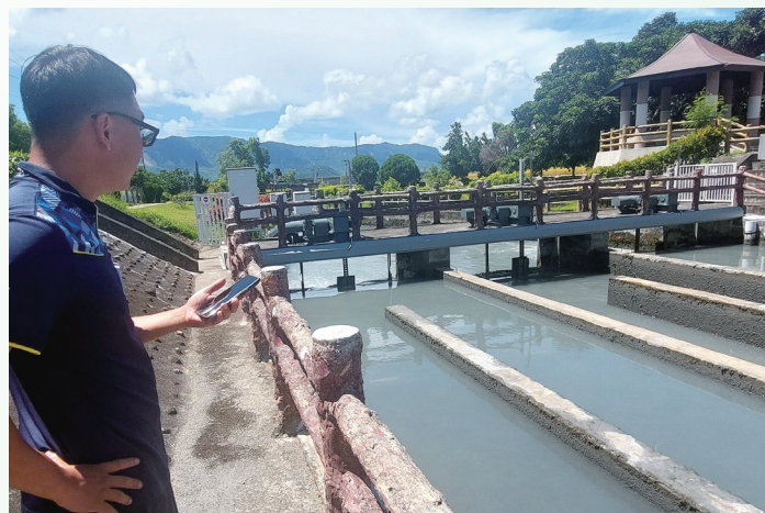
上 莊進忠處長建議開發卑南溪支流的伏流水 下 臺東管理處率先安裝水門遠端遙測系統
