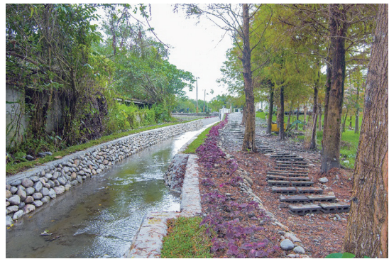
優良農業工程建設獎「水源地排水水源四中排(第一期)渠道改善工程」
