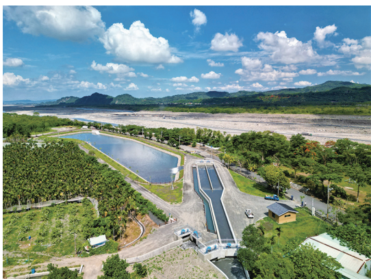
舊寮圳幹線調蓄設施強化工程全景
