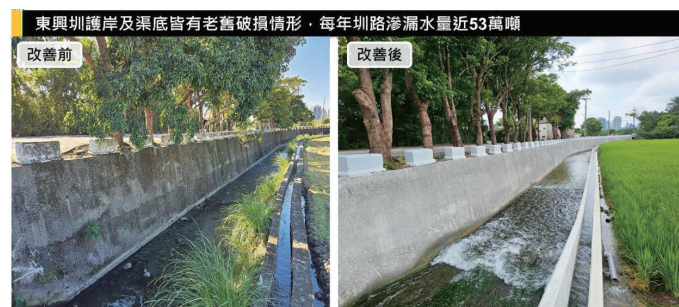
對策 以就地取材卵石及單純RC渠牆進行整體渠道改善
