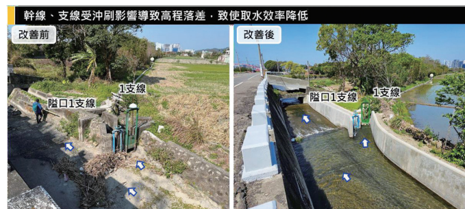
對策 調整渠道坡降及分水工高度確保支線取水量
