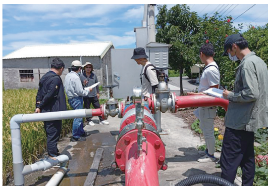
臺中管理處轄管抗旱水井現地抽檢作業
