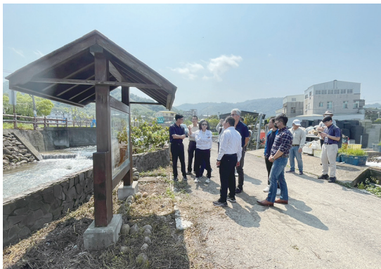
「明德水庫週邊營造地方創生景點」及「苗27線發電水車意象觀景台老舊暨穿龍圳橋面破損案」場勘
