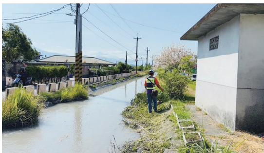
共通橋上游圳路兩岸之雜草已立即安排廠商進場修剪
