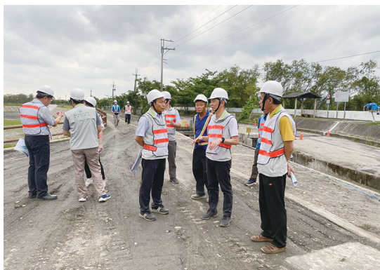
蔡署長蒞處黃處長率工程團隊陪同前往高樹鄉工地督導
