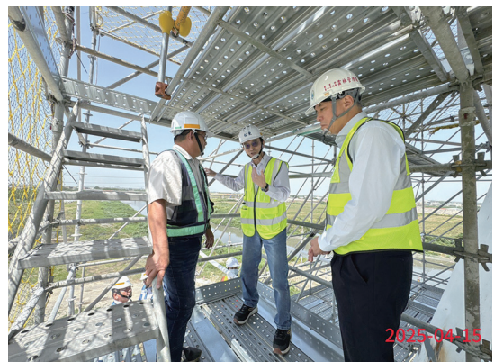
朱世禹教授於現場施工場域提醒注意事項
