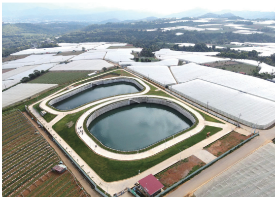
上 圖埔里大坪頂台地灌溉區域分布圖 下 大坪頂六萬噸調蓄池完工空拍照片
