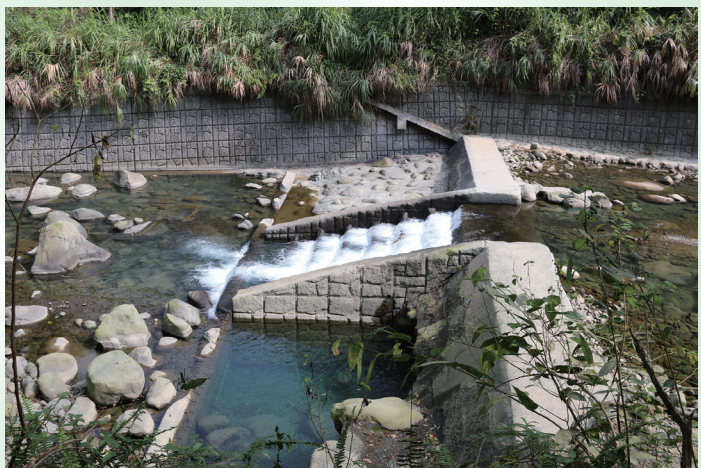
北勢溪階梯式跌水工，可消耗水流能量以減緩對河床的掏刷
