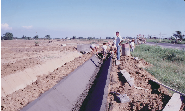
右一 土溝存在的年代久遠，迄今仍有未更新改善的土溝 右二 土圳易因外力破壞，得頻繁修整 右三 農地重劃是水圳改善的大躍進時期 右四 農地重劃將土溝改為內面工水圳，強化結構
