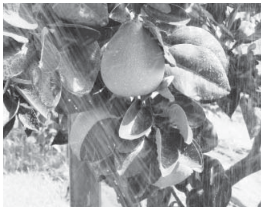
管路灌溉設施已成為文旦園的標配
