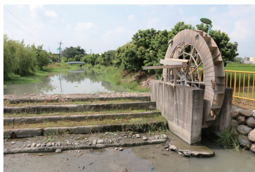
景觀水車完成修繕，為泉水埤公園裡特色景致
