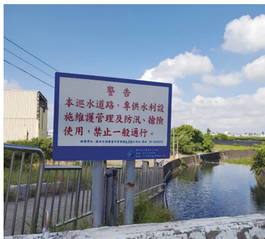
旱溝聯絡渠道制水閘（農水署列管水門）旁巡水通路告示牌
