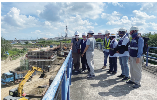
主任工程師(左二) 於施工現場視察
