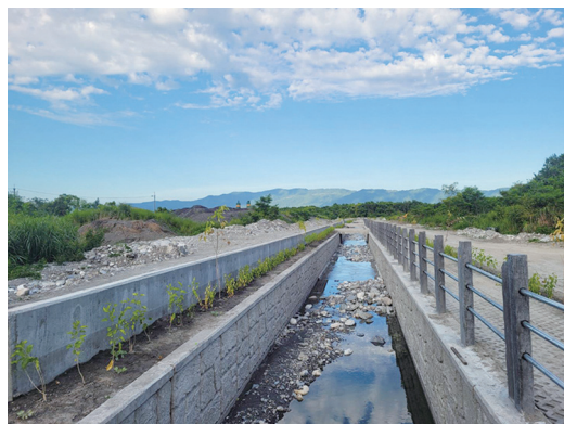
豐田圳第2進水口導水路改善工程
