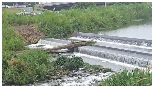
宜蘭河充館圳攔河堰補強工程
