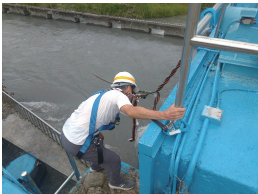
大光明圳渠首工安檢
