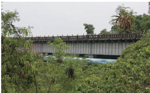
渡仔頭溪渡槽橋橫跨渡頭溪
