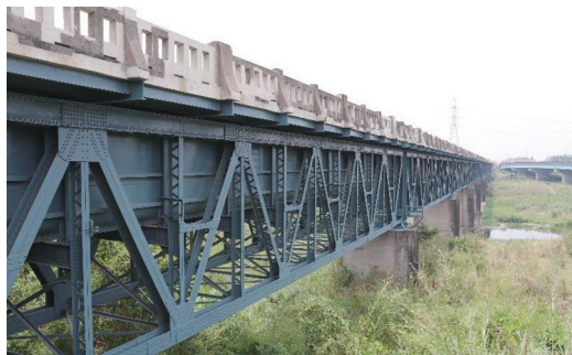
曾文溪渡槽橋於1929年竣工，為兼具水路及道路用途的「水人橋」
